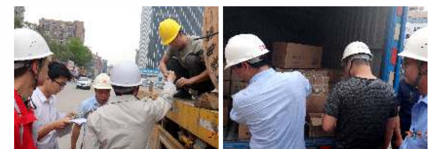
(电缆进场验收)
